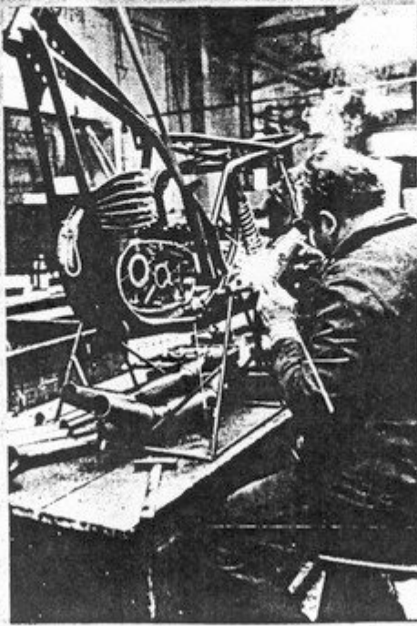
De assemblage van de motorblokken. Het tempo ligt niet bijzonder hoog; nauwkeurigheid komt op de eerste plaats.
